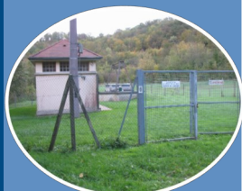
Captage de Coupigny/Montlevon
