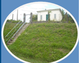
Captage de Monthiers
